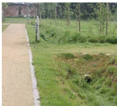
Figure 8 : a-aménagement avec revêtement perméable ; b-fossé végétalisé permettant le stockage et l'infiltration des eaux pluviales
