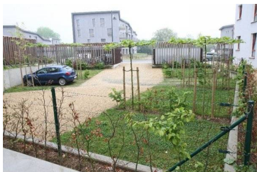
Figure 8 : a-aménagement avec revêtement perméable ; b-fossé végétalisé permettant le stockage et l'infiltration des eaux pluviales
